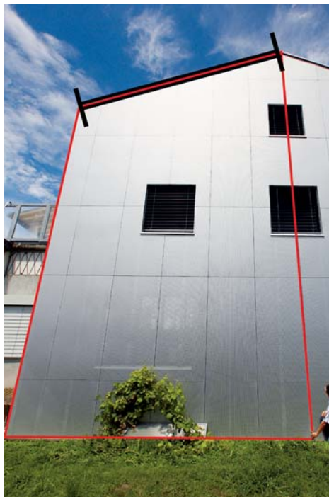
La funzione Trapezio facilita la misura dell'inclinazione dei tetti.
